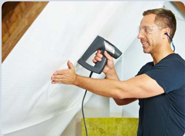
Fijación sencilla de láminas en trabajos de ampliación de áticos.
