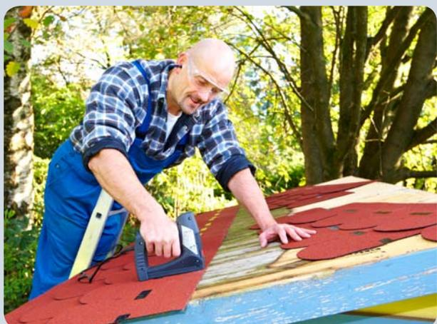
Fijación rápida de tejas de asfalto al tejado.
